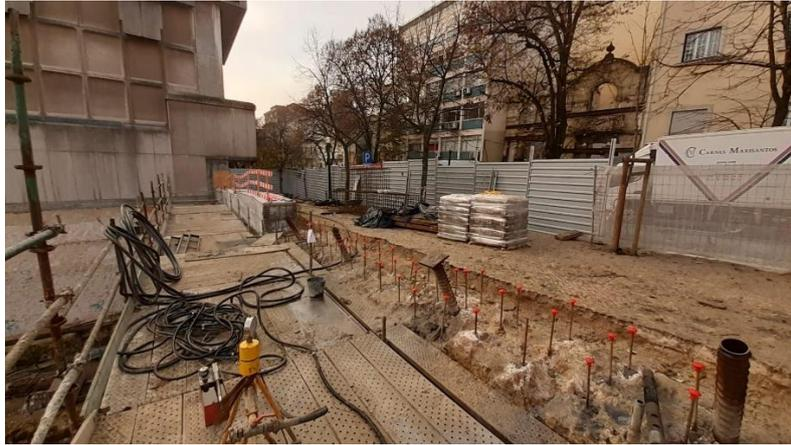
Figura 15 - Viga de reforço com microestacas executadas. Foto data de dezembro de 2019.
