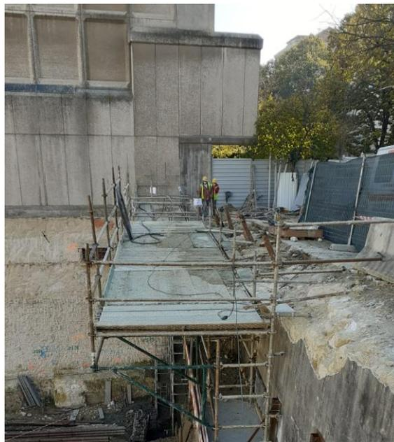
Figura 17 - Plataforma de apoio à execução das microestacas de travamento ao muro de gravidade centenário. Foto datada de dezembro de 2019.
