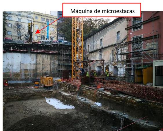
Figura 7 - Execução da viga de reforço e microestacas no topo do muro. Foto datada de dezembro de 2019.
