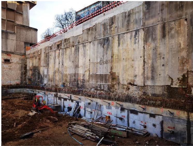
Figura 16 - Muro de Berlim definitivo com os dois primeiros níveis de ancoragens executados. Foto datada de dezembro 2019.
