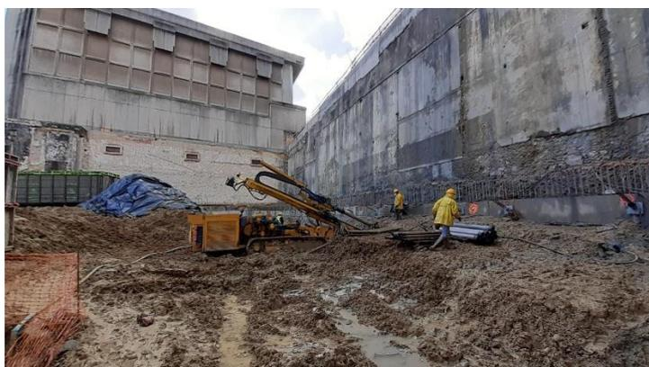
Figura 19 - Execução de ancoragens no Muro de Berlim Definitivo. Foto datada de dezembro de 2019.
